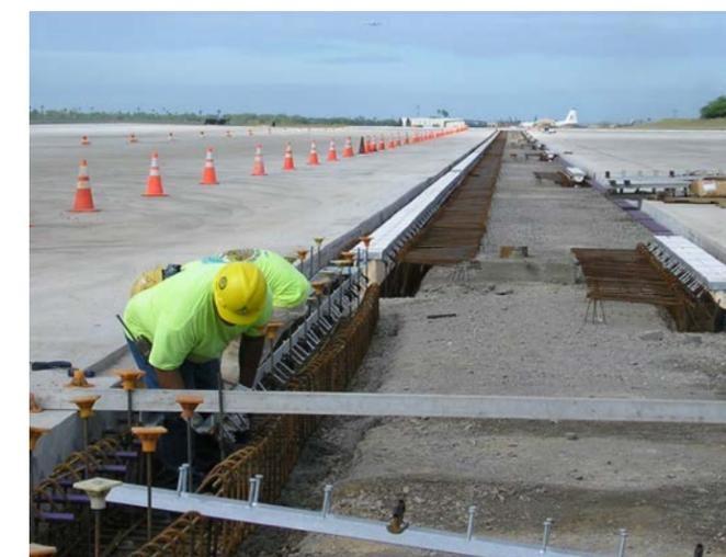
Les dispositifs et méthodes de coffrage de tranchées brevetés permettent à l'entrepreneur de réduire la main d'œuvre sur le chantier et de réduire les délais de construction, tout en fournissant au propriétaire et à l'ingénieur un produit de meilleure qualité, et ce, grâce à la pré-ingénierie des pièces critiques et, parfois, à l'envoi d'assemblages complets au projet en cours.
