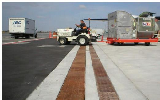
Le système XHD n'utilise pas de revêtements non amovibles qui créent un risque de rupture en étant pris en sandwich entre le cadre et le béton. Ces systèmes de revêtement répandent les défaillances en raison de leur faible résistance à la compression, de leur fluage et de leurs propriétés d'expansion thermique.
